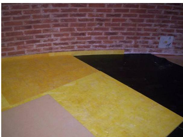
Fotografía 3. Piso flotante. Detalles constructivos
