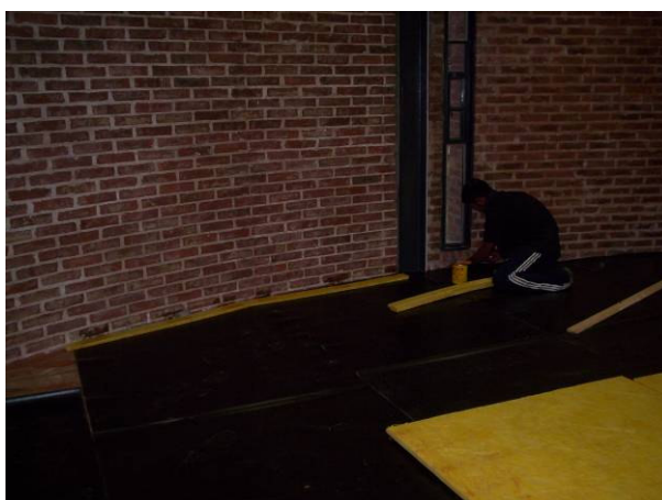
Fotografía 4. Colocación de zócalos
