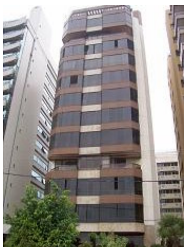
Figura 4. Edificação residencial, construída em 1984, com varandas em toda a fachada, revestimento cerâmico e esquadrias com vidro fumê .
