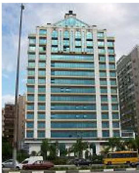
Figura 6. Edificação residencial, construída em 1997, com esquadrias sem caixilho e vidro colorido verde.
