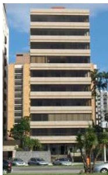
Figura 7. Edificação residencial, construída em 1972 e reformada nos anos 90, quando recebeu fechamento da sacada.
