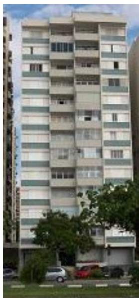
Figura 3. Edificação multifamiliar construída em 1968, onde é possível observar a presença de pequenas varandas e esquadrias de correr. Fonte: Fotos do autor.
