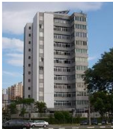
Figura 5. Edificação residencial, construída em 1980, em concreto aparente como elemento compositivo das fachadas.
