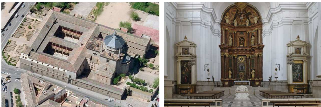
Fig. 1. Vista aérea del Hospital e interior de la Iglesia [3].
