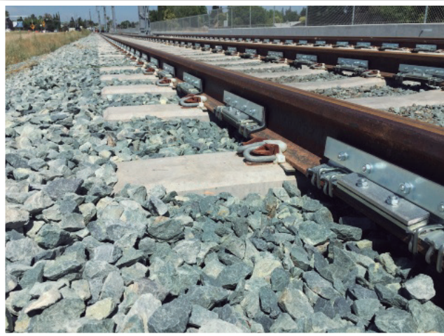
Figura 3. Rail dampers del fabricante Voestalpine instalados en una vía con balastro [18].
