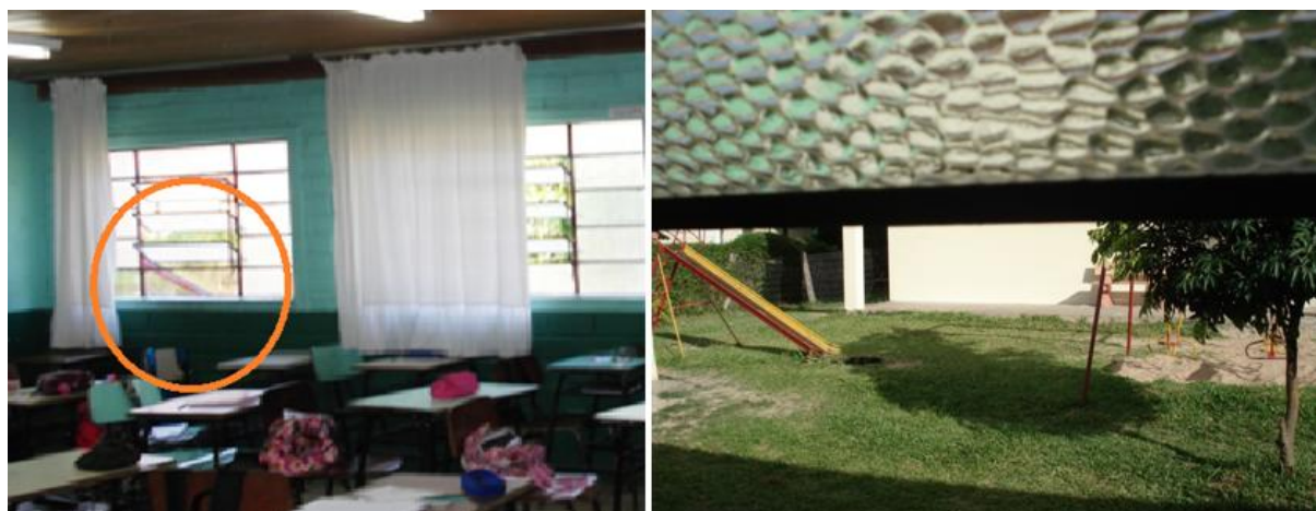
Figura 3 - Pracinha ao lado da janela da sala de aula pode colaborar para o aumento do ruído de fundo da Escola Municipal Duque de Caxias.
