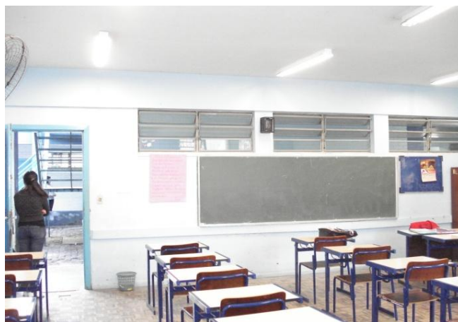
Figura 6 - Escola Cícero Barreto, janelas voltadas para o pátio da escola podem contribuir com o aumento do ruído de fundo da sala.
