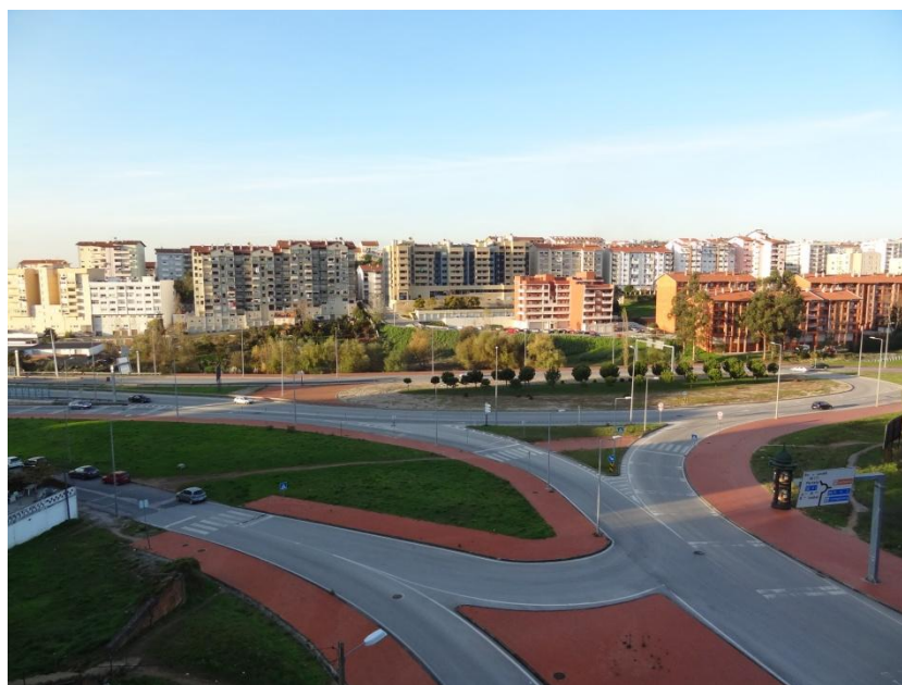
Figura 6 – Vista da zona frontal à fachada do LAI.
