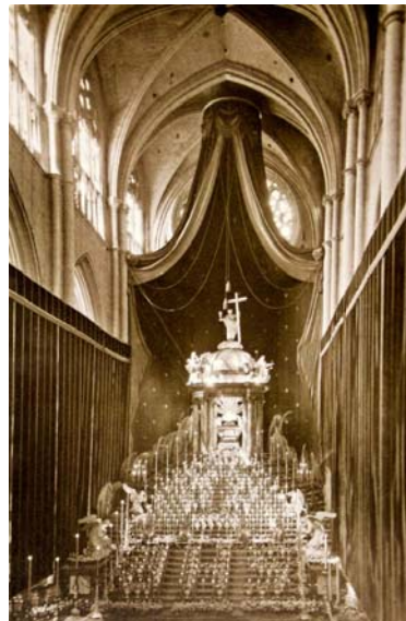
Figura 2 – Monumento de la Semana Santa en la nave central de la Catedral de Toledo
