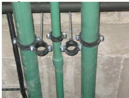
Figura 1: Abrazaderas desolidarizadas
