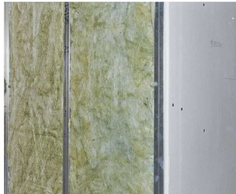
Figura 5: Solución constructiva de placas de yeso laminado y lana mineral URSA TERRA
