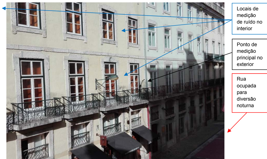
Figura 1 – Imagem do alçado principal do edifício em estudo e localização dos pontos principais de medição de ruído ambiente e de avaliação de isolamento de fachada.
