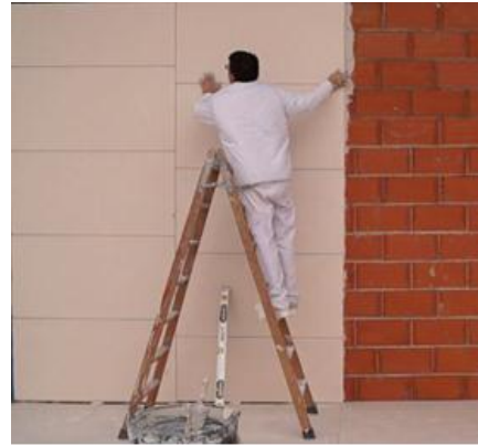
Figura 4.- Pared de ladrillo con revestimiento de PYN (Placa de Yeso Natural)
