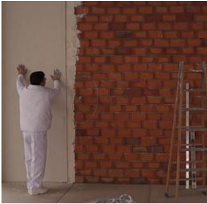
Figura 3.- Pared de ladrillo con revestimiento de PYL (Placa de Yeso Laminado)
