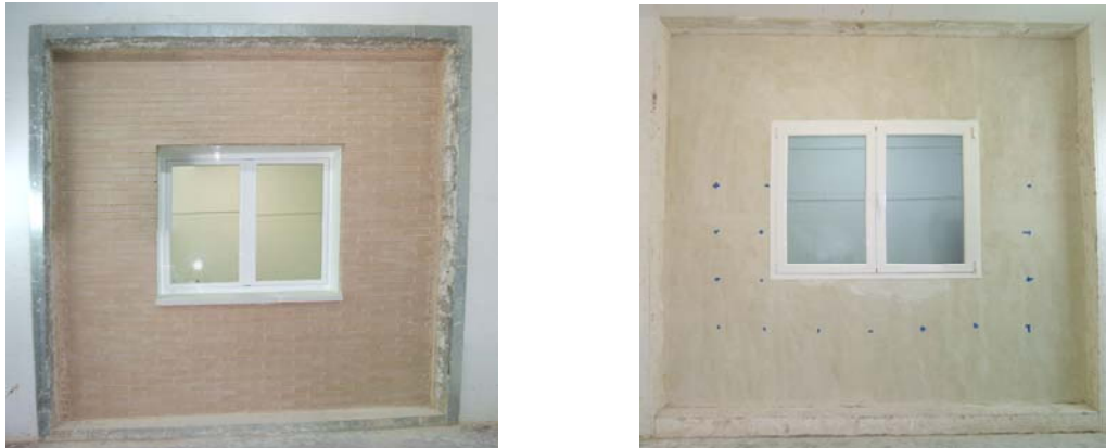
Figura 3. Vista exterior (Izqda) e interior (Dcha) de la fachada.
