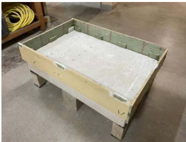
Figura 3. Encofrado para losa flotante.
