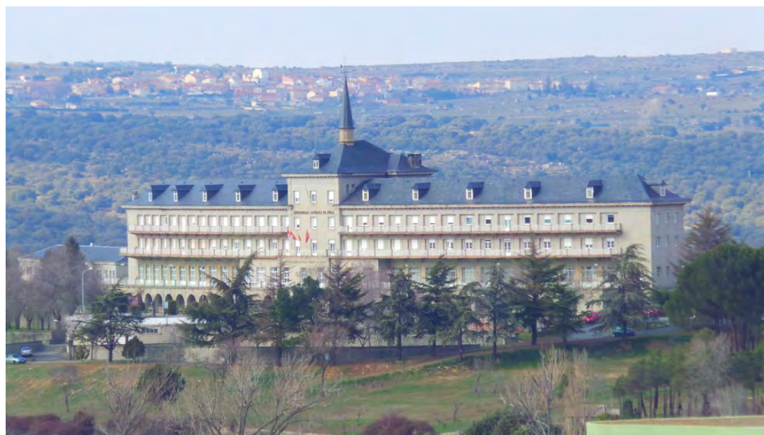
Histórico edificio de la Fundación Santa Teresa de Ávila
